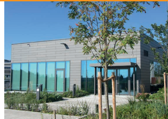
Die Energiezentrale II ist fertig
