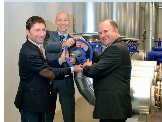
Die Wärmeversorgung durch die EZ II läuft seit diesem Jahr
