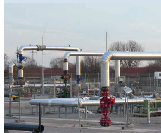
4 Rohrbögen = 4 erfolgreiche Bohrungen
