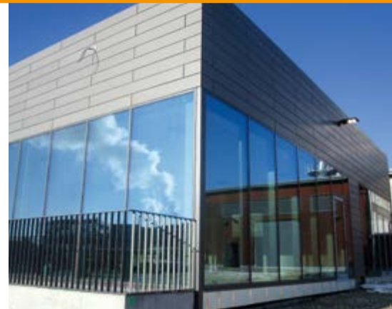
Bringt Wärme in den Süden: Die neue Energiezentrale.
