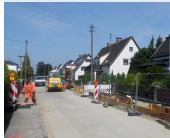
Verlegung von Fernwärmeleitungen in der Ringstraße.
