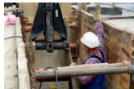
Einziehen der Spundwände.
