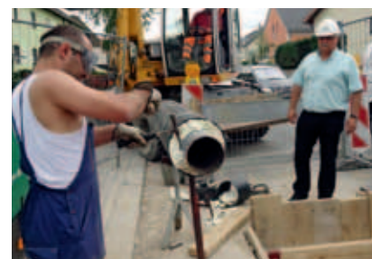
Anpassen der Rohre.
