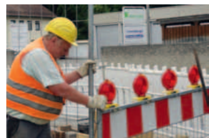
Sichern der Baustelle.
