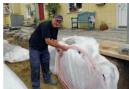
Verlegung der Glasfaserrohre.
