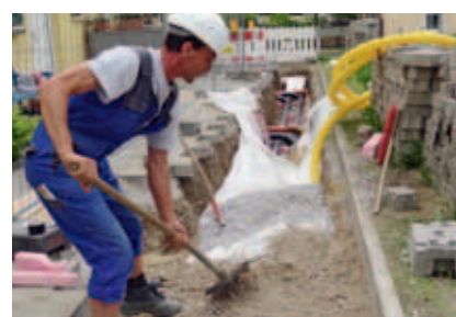
Einsanden und Rückbau.
